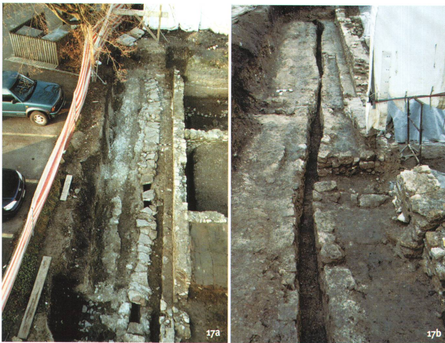
Fig. 17a-b Vindonissa. Canalisazione in maçonnerie qui se trovait sous la Lagergasse et qui longeait autrefois la partie septentrionale des principia ; situation avant et après l'enlèvement des dalles de couverture (fouilles de Römerblick en 2004).
