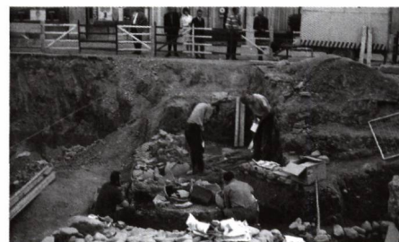
Marc-Rodolphe Sauter (debout à droite) sur le chantier d'un grand magasin, place De-Grenus, en 1964. Vue vers le nord.
