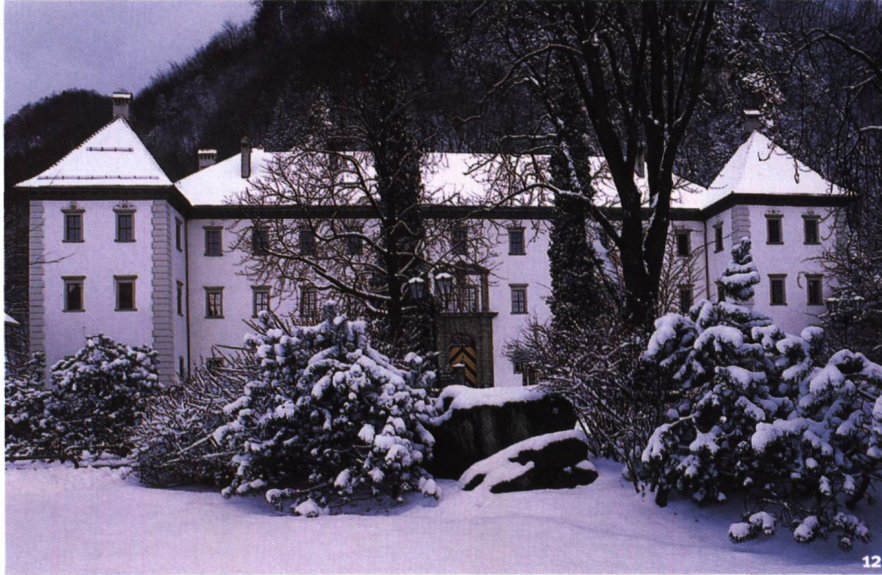
Abb. 12 Palast Hohenems (A). Mit dem Aufstieg der Ritter von Hohenems in der Mitte des 16. Jahrhunderts in den Reichsgrafenstand erbaute sich die wohlhabende Familie eine prächtige renaissancezeitliche Residenz. Ansicht von Westen.
