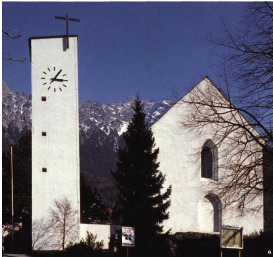
Fig. 4 Schaan, chapelle Saint-Pierre (FL). Vue de l'ouest.
