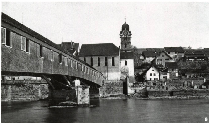
Abb. 8 Holzbrücke und Kirche von Eglisau im April 1917. Die Häuser an der Rheingasse waren wegen des bevorstehenden Rheinstaus zu diesem Zeitpunkt bereits abgebrochen.
