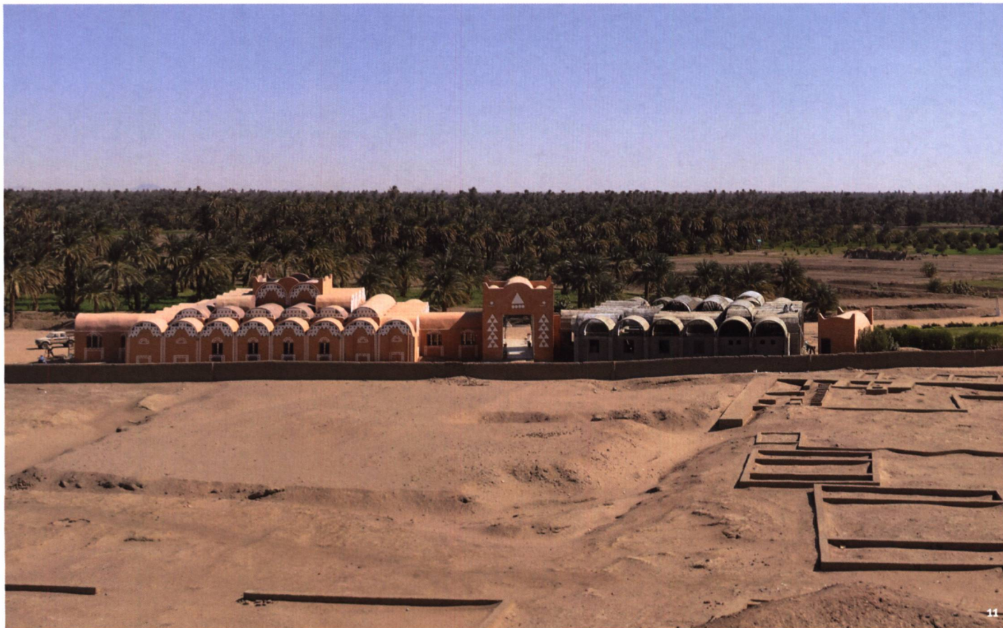
Fig. 11 Vue du musée de Kerma et du centre culturel en cours de construction, consacrés à la Nubie.
