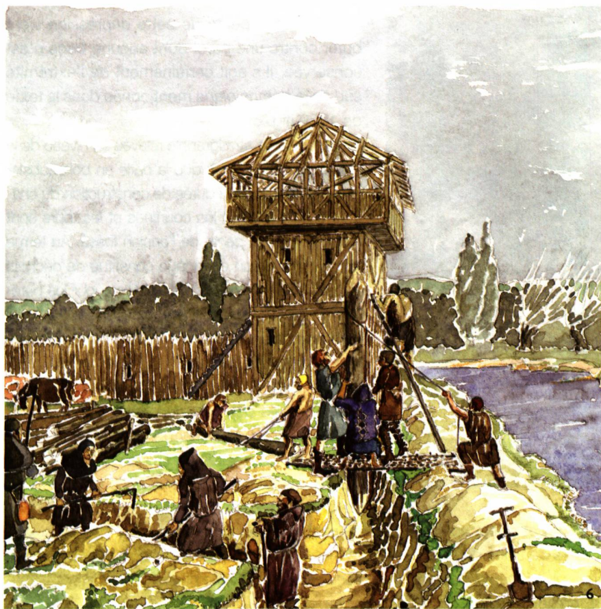
Fig. 6 Restitution du chantier de construction de la bâtie en bois durant l'été 1318.
