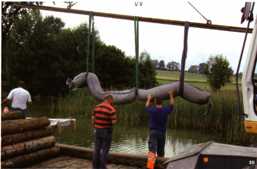
Abb. 10 Stabilisierung der von Erosion bedrohten Kliffkante bei der Station Risch-Buonas (2009).
