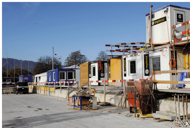
Abb. 2 Das Schulprojekt der Grabung Parkhaus Opéra reiht sich in die Infrastruktur für den Bau des Parkhauses ein: Zwei blaue Dreifachcontainer und ein Zelt stehen für Workshops mit jeweils zwei Schulklassen zur Verfügung.
