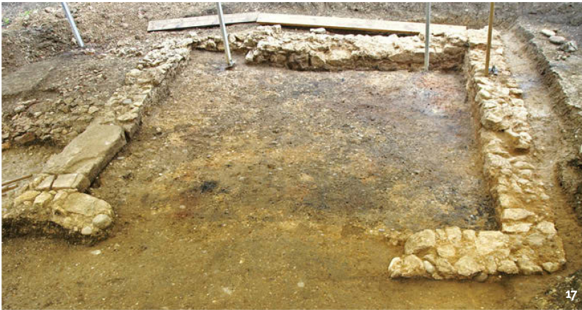
Abb. 17 Pratteln-Meierhof. Fundamentreste des Halbkellers des mittelalterlichen Kernbaus. Blick vom jüngeren Anbau aus, dessen Mörtelboden bereits abgetragen ist.
