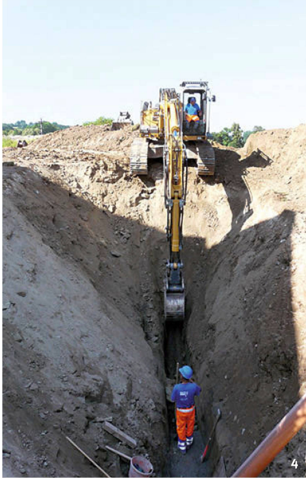
Abb. 4 Faoug. Überwachung der Aushubarbeiten für einen Leitungsgraben im Jahr 2007.
