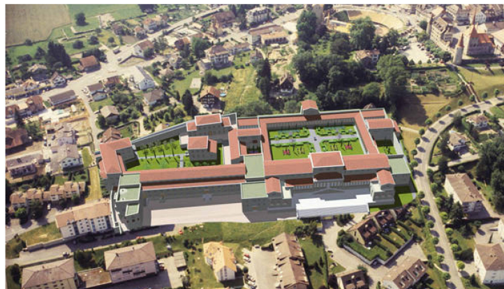
Avenches. Visualisierung des Palais de Derrière la Tour in der heutigen Umgebung.
