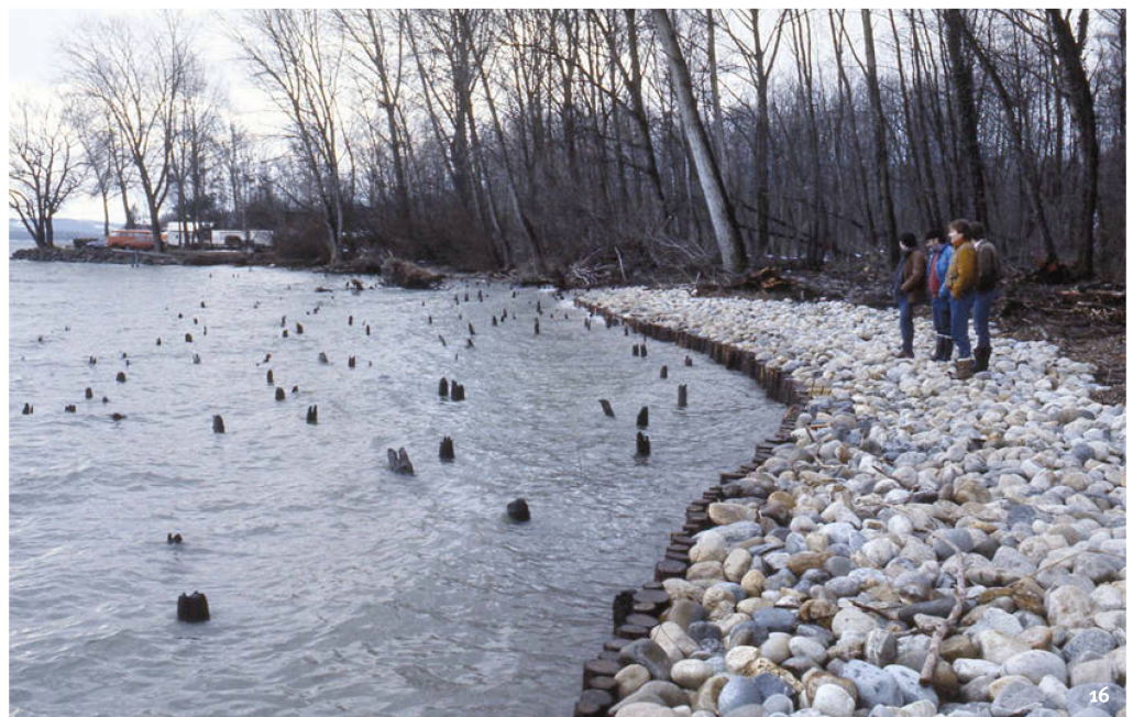
Fig. 16 Grandson – Corcelettes I. Ouvrage de protection de la station littorale du Bronze final (de -1062 à -878 av. J.-C.), mis en place en 1987 pour lutter contre l'érosion naturelle de la rive.
