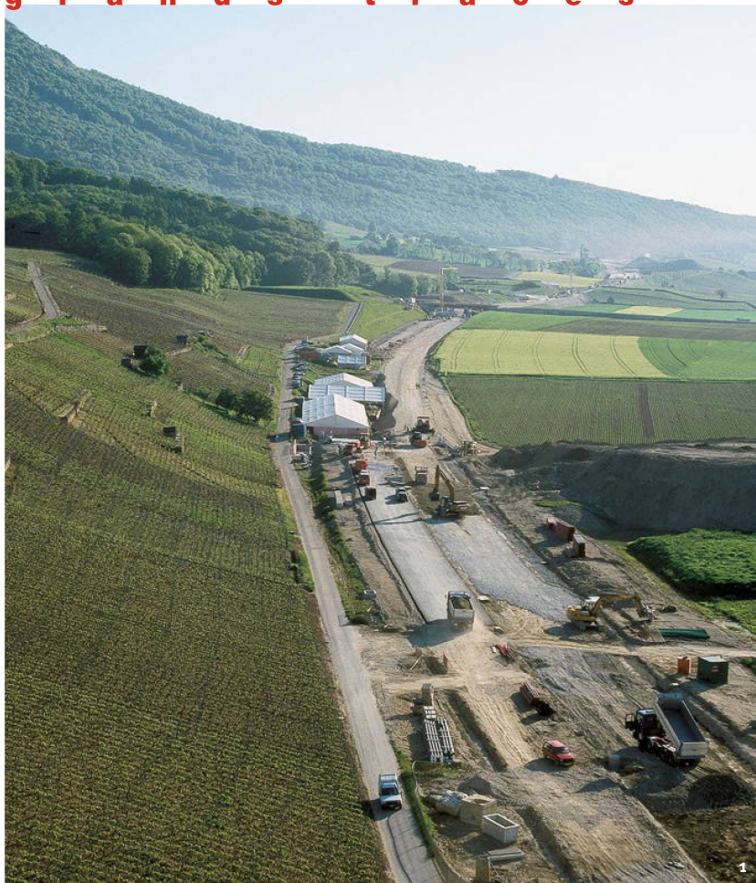
Fig. 1 Fouilles A5. Onnens – Praz Berthoud (à la hauteur des tentes), au pied du Jura. Au premier plan, début des travaux de construction de l'auto- route (juin 2002).
