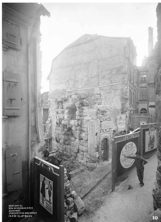
Fig. 10 Dégagement des vestiges de la Maleporte en 1921.
