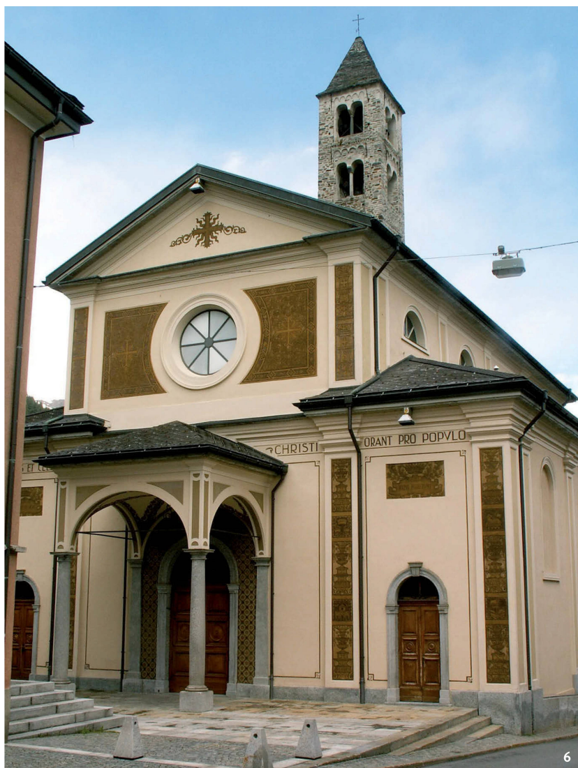
Fig. 6 Airolo, chiesa parrocchiale dei SS. Nazario e Celso. Facciata. Airolo, chiesa parrocchiale dei SS. Nazario e Celso. Fassade. Airolo, façade de l'église paroissiale SS. Nazario e Celso.
