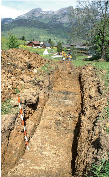
Abb. 12 Ziel der 2007 gegründeten Kommission für Archäologie und Raumplanung ist es, die archäologischen Fundstellen bereits in der Raumplanung zu erfassen und zu schützen. Ausgrabung eines Kontrollschnittes mit dem Bagger an der projektierten Baustelle Klanghaus Toggenburg, Schwendiseen (SG).
