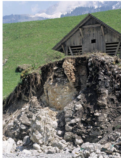
Ruine des Hochofens mit aufgerissenem Schacht nach der Rodung; Blick von Südwesten am 11.05.2006. Die doppelkonische Form des Schachtes tritt an der Abrisskante deutlich hervor.
