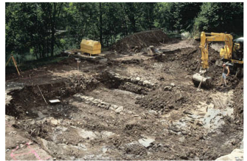
Blick in die Baugrube.
