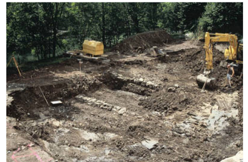
Vue de la fouille.
