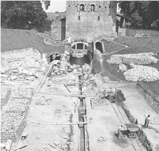
Fig. 2 Travaux de dégagement de l'amphithéâtre (1943).
