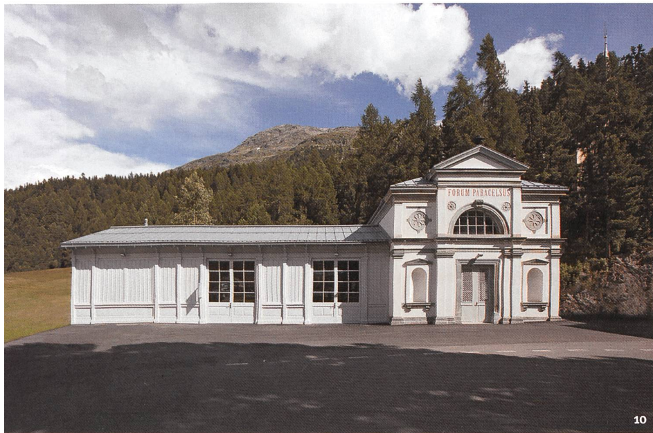
Abb. 10 Das Forum Paracelsus nach abgeschlossenen Restaurierungs- und Sanierungsarbeiten im Sommer 2014.
