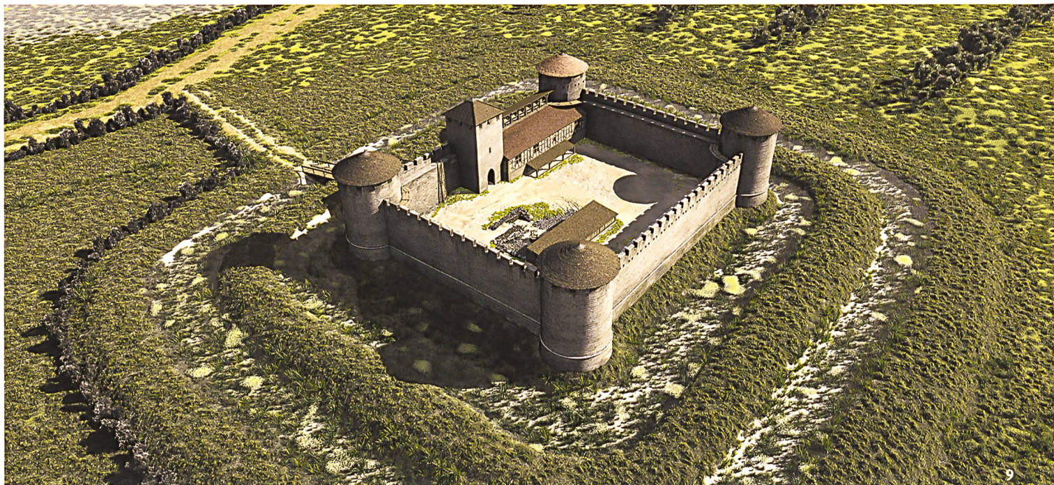
Fig. 9 Restitution du château en pierre, vu depuis le nord-ouest. La domus plana a été démantelée et remblayée en conservant le puits. Le corps de logis est construit contre la courtine est.
