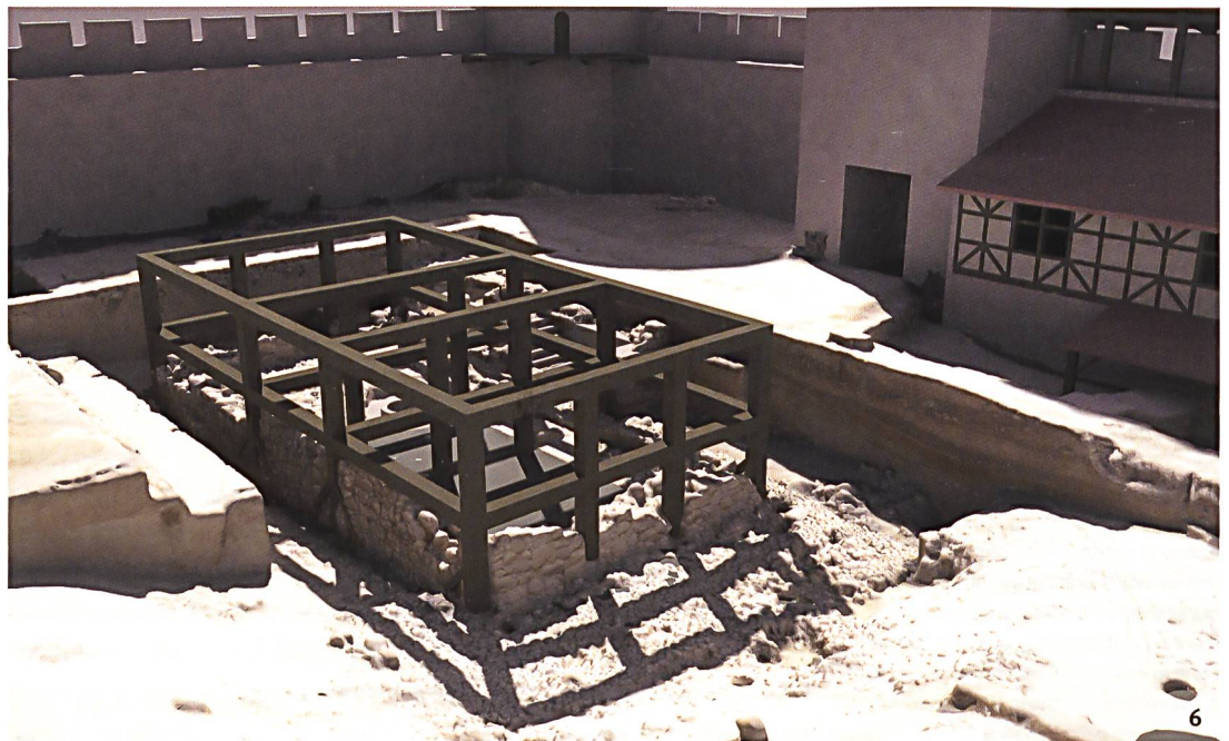
Fig. 6 Restitution de la structure en bois de la domus plana . Les poutres et bras de force sont bien visibles.
