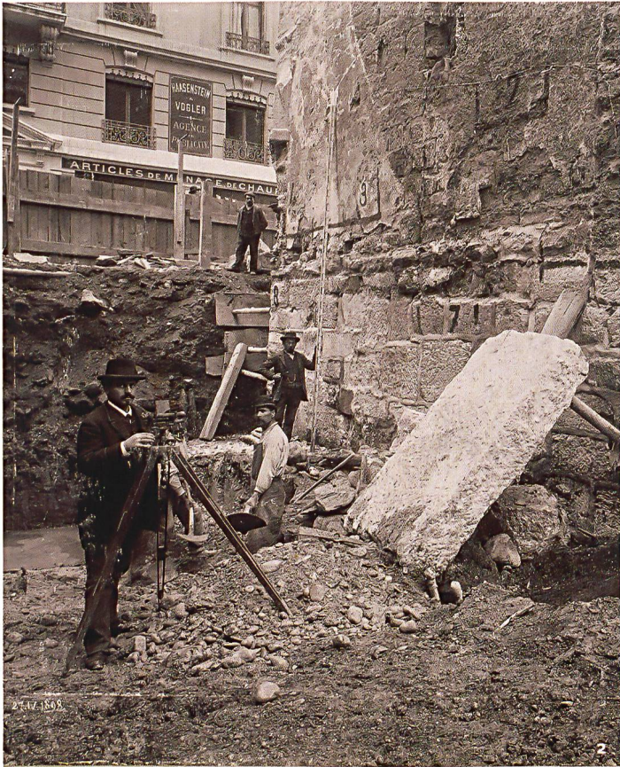
Fig. 2 Vue des fondations de la Tour de l'Île, dégagées en 1898.
