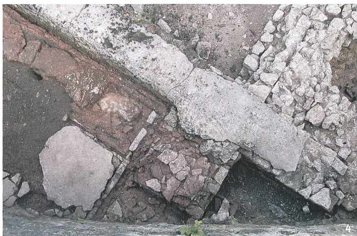
Abb. 4 Bauliche Überreste der ersten Phase. Links: Reste des Hypokaustums, das später zu einem Becken umgebaut wurde; in der Mitte: das zugebaute praefurnium ; oben rechts: der dicke Estrich eines der gepflasterten Räume; oben: das frigidarium , des- sen Fussboden nicht erhalten ist.
