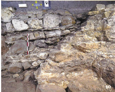
Fig. 10 Fondations du bas-côté sud de l'église romane. A droite, la maçonnerie a été soigneusement terminée, avant la reprise des travaux avec le mur de gauche.
