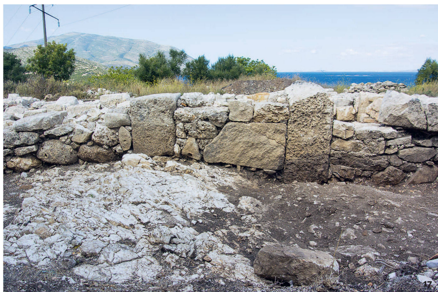
Fig. 17 Porte aménagée dans la façade méridionale de l'église sud, condamnée ultérieurement.
