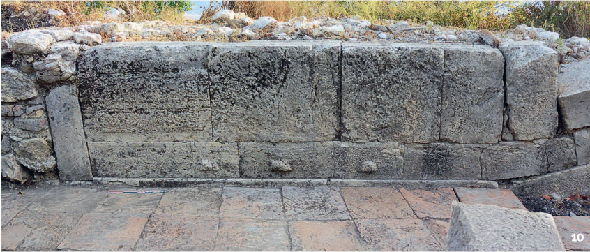
Fig. 10 Mur fait de blocs disposés verticalement (orthostates), antérieur à la construction du théâtre.
