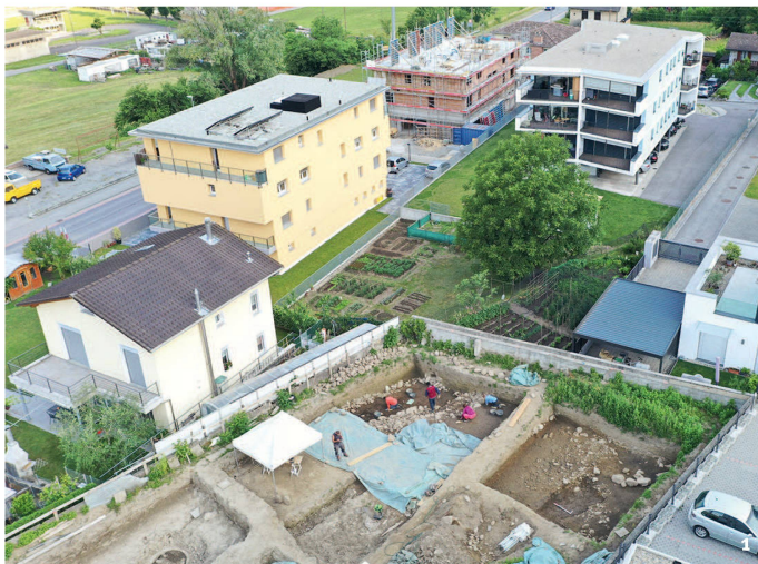
Fig. 1 Bellinzona-Claro, località Longo. Veduta generale del cantiere 2020-2021; sullo sfondo le due palazzine in costruzione sui mappali indagati nel 2018-2019. © Briva.
