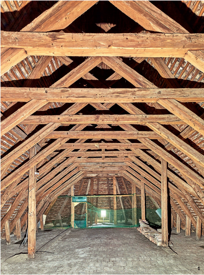
Abb. 1 Der Chordachstuhl von 1279 mit Verstärkungen von 1397. Blick nach Osten. © P. Joner, ADB.
