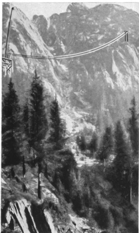
Wie eine Freileitung überbrückt das selbsttragende Luftkabel die grössten Spannweiten
