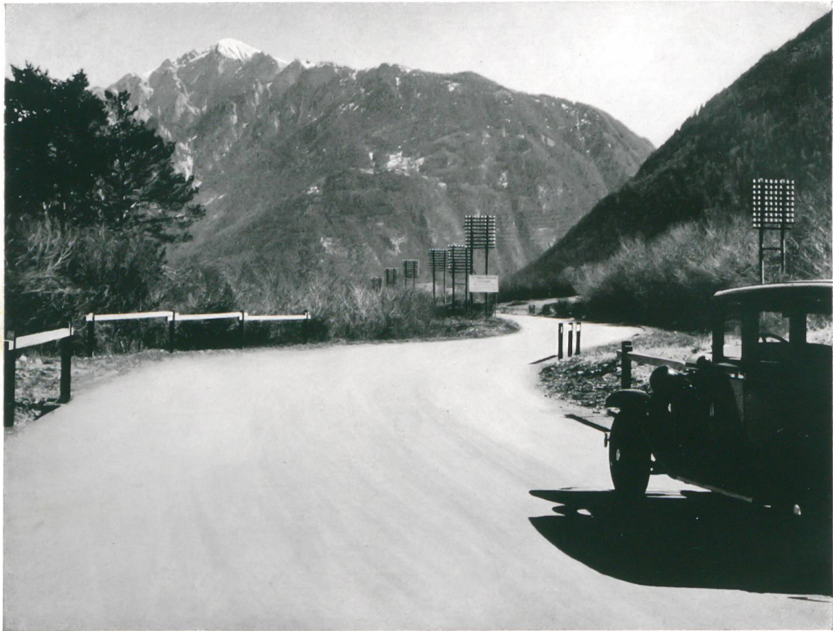
STRASSE CHUR-EMS, HALBTRÄNKUNG MIT KALTASPHALT UND OBERFLÄCHENBEHANDLUNG MIT SPRAMEX
