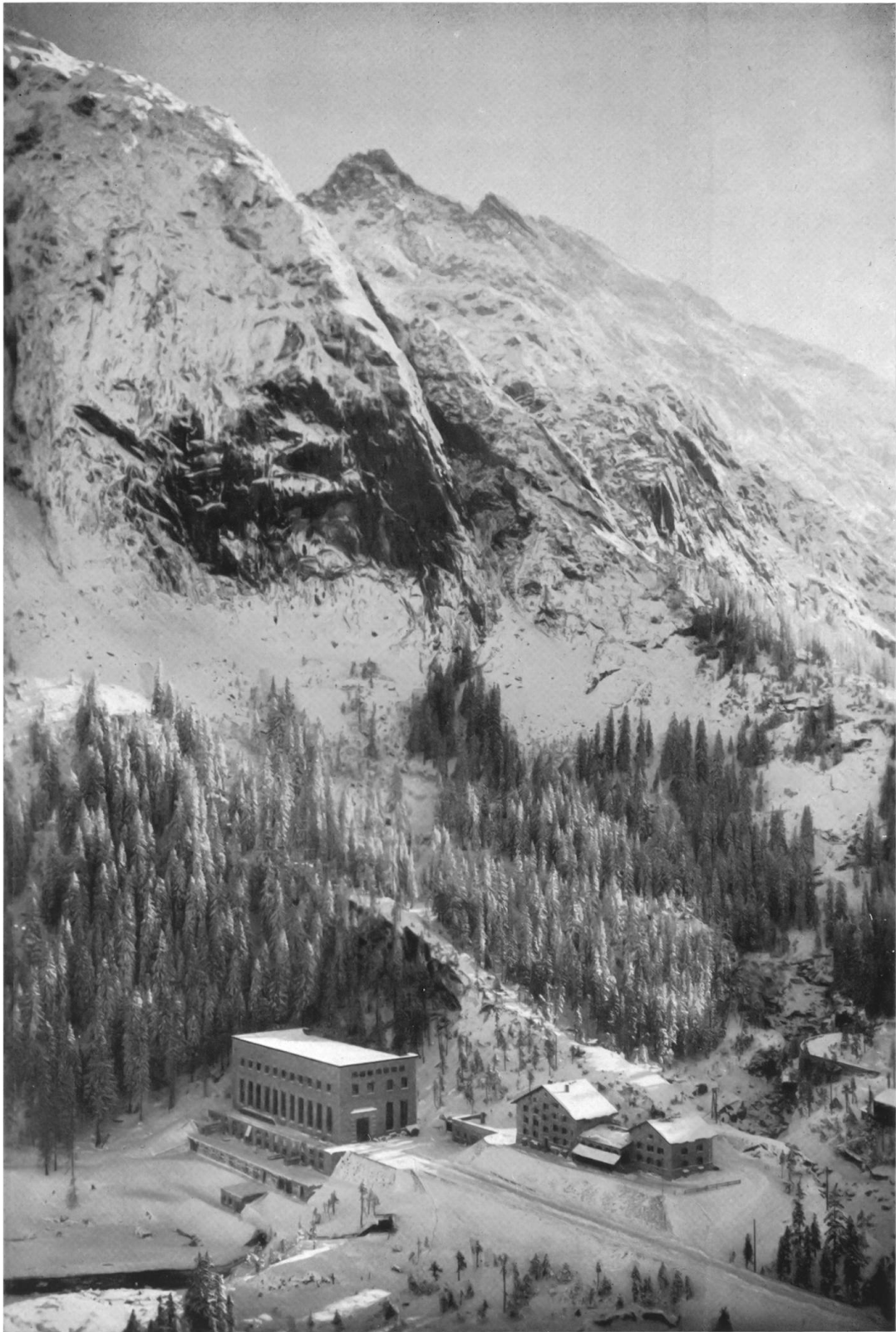
Zentrale Handeck und Maschinistenhäuser.
