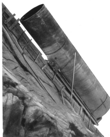
Rohrtransport auf der Standseilbahn. 106% Steigung.
