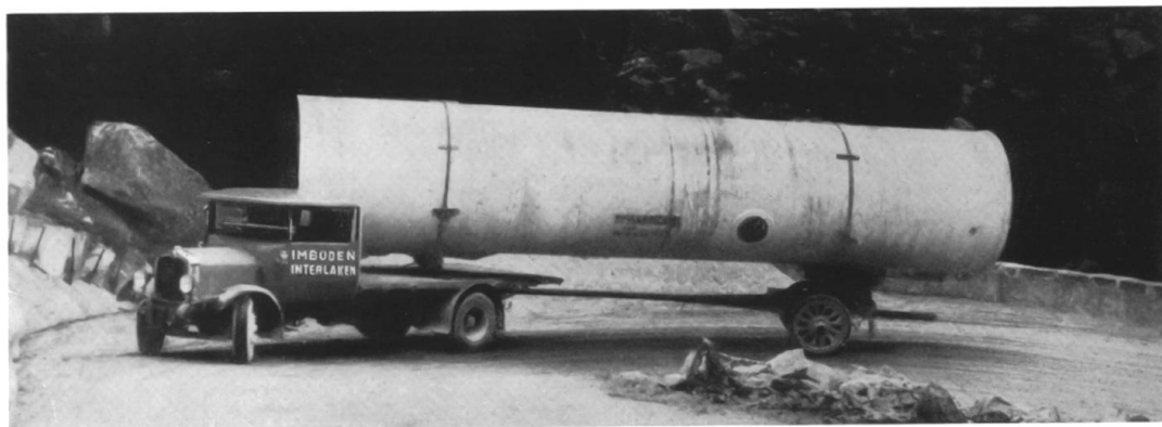
Transport eines 9 t schweren Rohres von 230 cm lichter Weite auf der Grimselstrasse.
