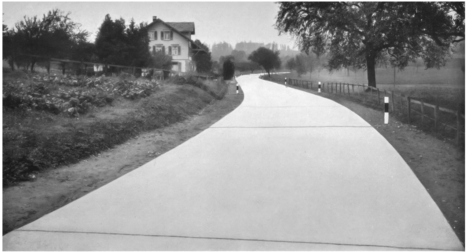
Betonstrasse bei Bischofszell, Kt. Thurgau
