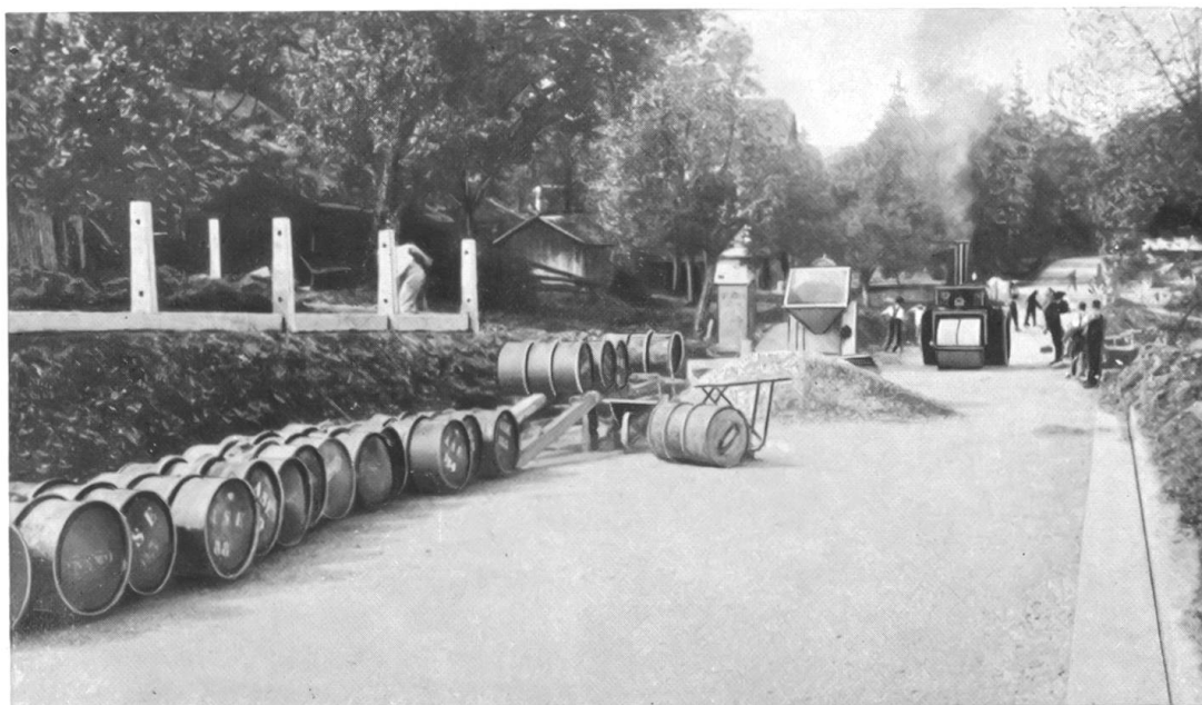
Baustelle eines Colzuma-Kaltemischbelages.
