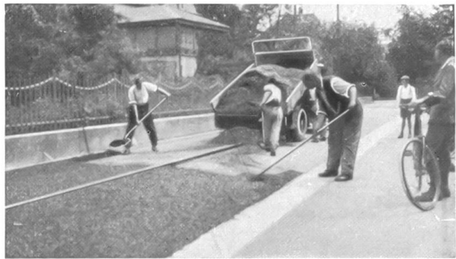
Einbau des Mischgutes.
