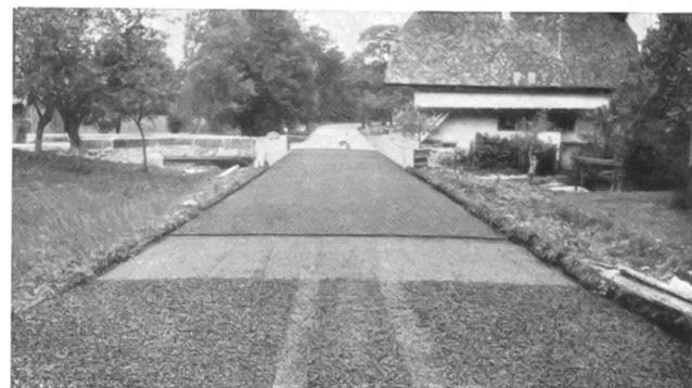
Zweischichtiger Belag beim Einbau.
