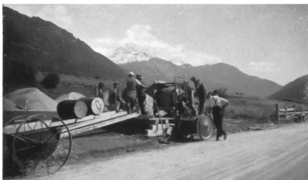
Einbau eines Colzuma-Mischbelages auf der Julierstrasse.
