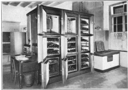
Spezial-Kühlschrank mit Glacé-Konservator im Kursaal Interlaken.
