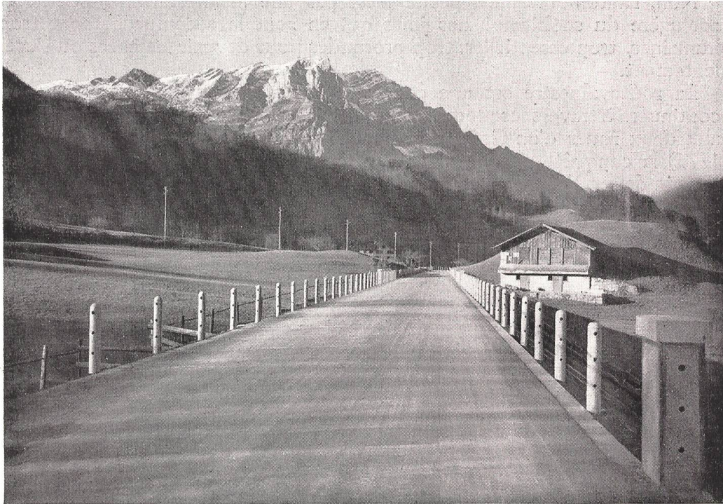
Strasse Mitlödi-Glarus. Walzasphaltbelag von Strassenbauunternehmung Palatini & Cellere, St. Gallen.
