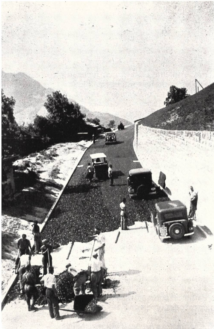
Strassenbelagsarbeiten am Kerenzenberg ohne Verkehrsunterbruch, ausgeführt durch Palatini & Cellere, St. Gallen.
