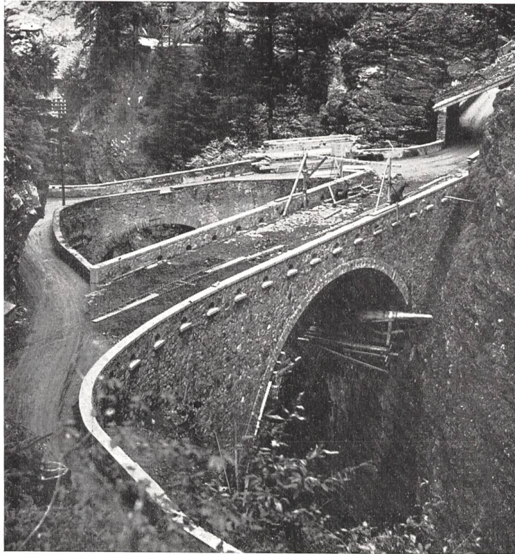
Die neue Brücke in der Viamala. Ausgeführt von L. Premoli, Bauunternehmer, Zillis.
