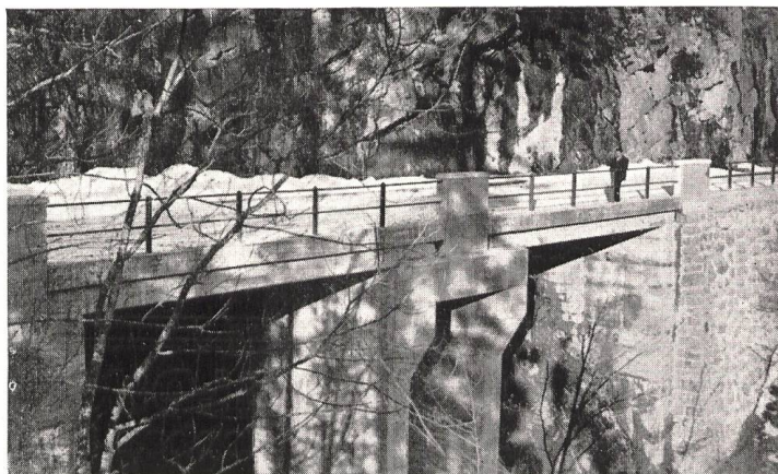
Letzibrücke an der Brünigstrasse
