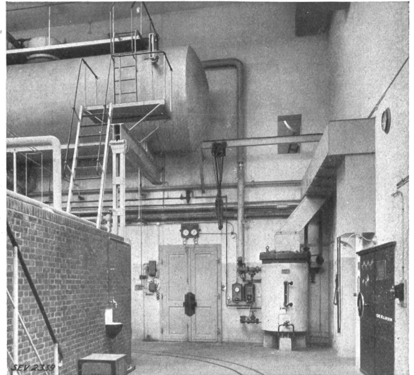
Fig. 9. Revel-Kessel im Frauenspital Basel (120 kW, 6000 V, 13 at).
