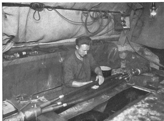
Fig. 17. Wickeln der Muffen. Links und rechts am Kabel sind die bleiernen Abschlusskappen zu sehen.
