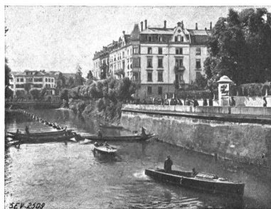
Fig. 16. Spitze des Kabelzuges im Schanzengraben.
