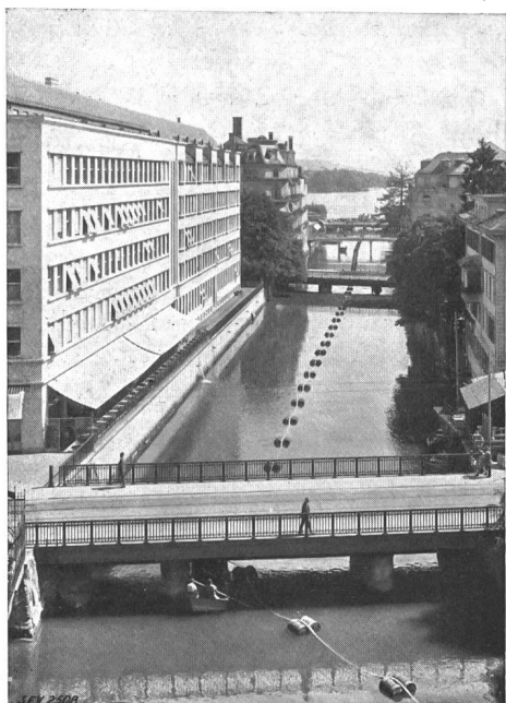
Fig. 15. Kabelzug im Schanzengraben.
