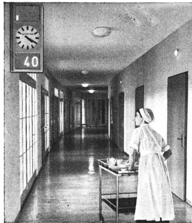
Fig. 2. Lichtruf- und Personensuchanlage in einem Kranken- haus
