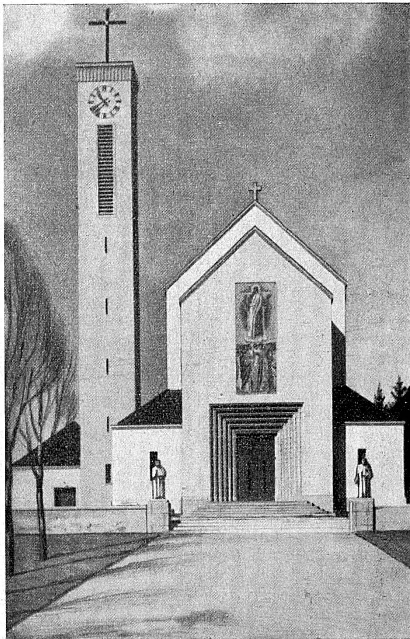
Eglise de Tavannes - Extérieur
