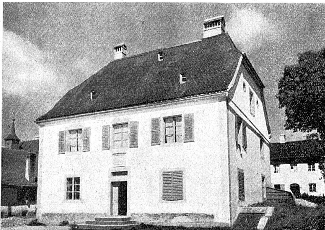
Le «Pavillon» construit en 1715 pour Abraham II Gagnebin, à La Ferrière.
