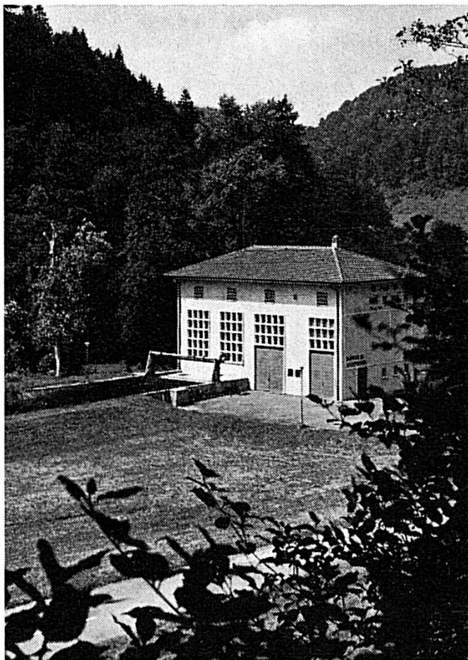
Centrale de Bellefontaine sur le Doubs
