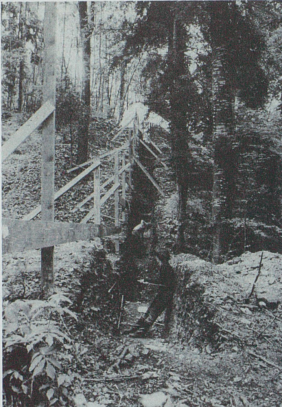
Fig. 5 – Sondage 1, vu en direction de l'ouest.
