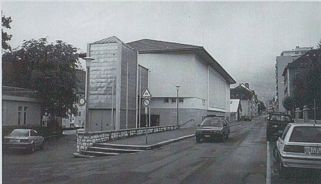
Saint-Imier. Annexe sans relation avec l'immeuble rénové (forme, matériaux...).
