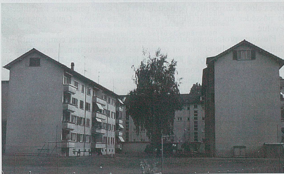
Immeubles locatifs à Delémont. Aménagements extérieurs négligés.
