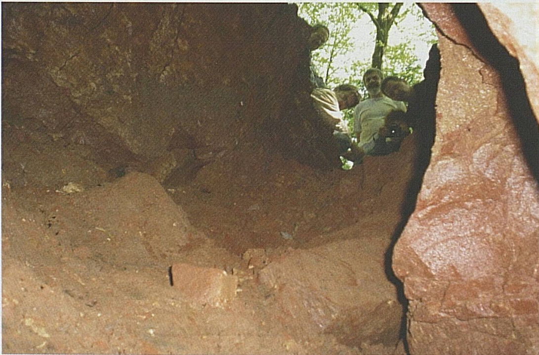
Fig. 7 : Vue sur l'extérieur à partir du fonds de la galerie d'accès.
