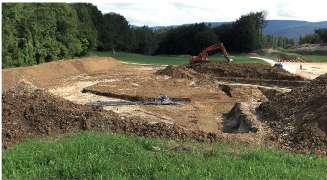
Fig. 2: Vue de la vallée sèche de Va Tche Tcha, commune de Courtedoux, avec la fouille d'une grande doline du type de celle de Boncourt, Neu Bois (voir colonne fig. 12), située sur le tracé de l'A16. Tout en arrière-plan vers le sud, on aperçoit les contreforts de la chaîne du Jura plissé. Photo D. Aubry.
