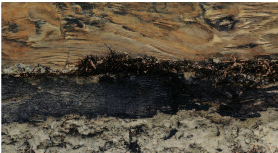
Fig. 8: Détail du joint de mousse. Photo P.-A. Borgeaud.
