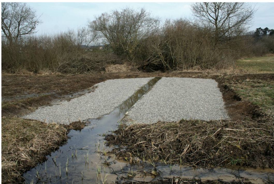
Fig. 8. Aménagement d'un bassin de filtration avec du gravier et une future plantation de roseaux, au sud-est des étangs des Cœudres, à Damphreux, 14.03.09. Photo: Philippe Bassin.
