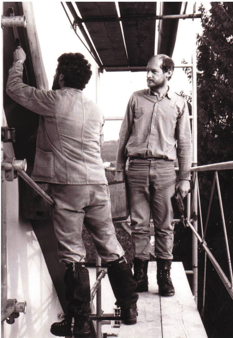
Photo 2. Pose de nichoirs pour martinets noirs (façade sud de l'aile centrale du bâtiment du Lycée cantonal). Avec Michel Rebetez, à gauche et Simon Lovis, à droite (Photo: Philippe Bassin).
