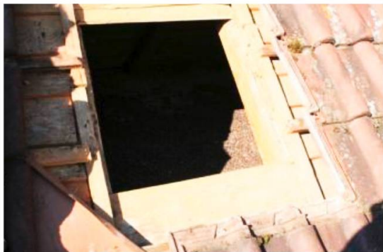
Fig. 3 : Toiture ouverte permettant d'accéder à l'abri où logent les sérotines communes.
